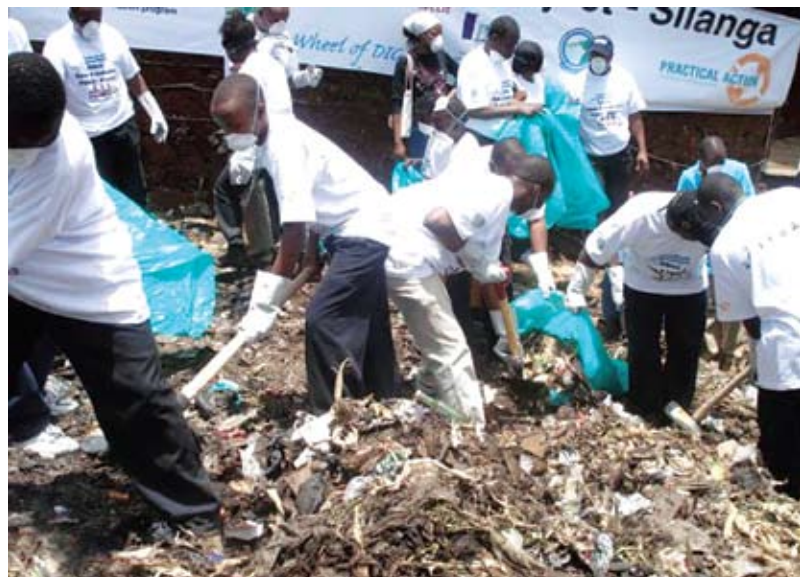
Rotarianos e membros da comunidade de Kibera limpam o terreno onde será construído um sanitário.
